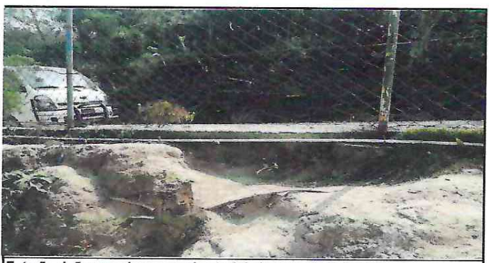
Foto 5: daños en el muro perimetral de la entrada de la escuela
